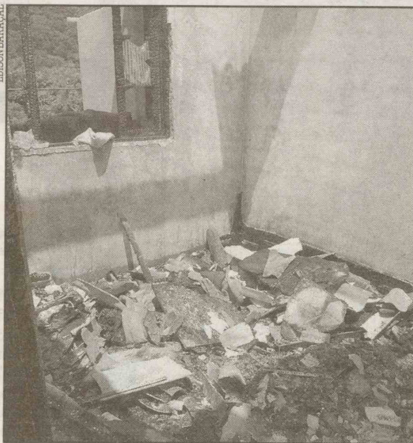
A casa ficou bastante destruída, inclusive sem partes do telhado
